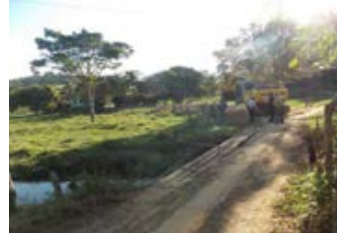
Início da construção da ponte no C. Cutieira
