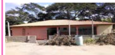
Escola Maria P. Storary está sendo reformada
