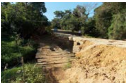
Velha estrutura de madeira foi substituída
