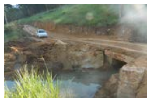
Ponte no Córrego da Peneira
