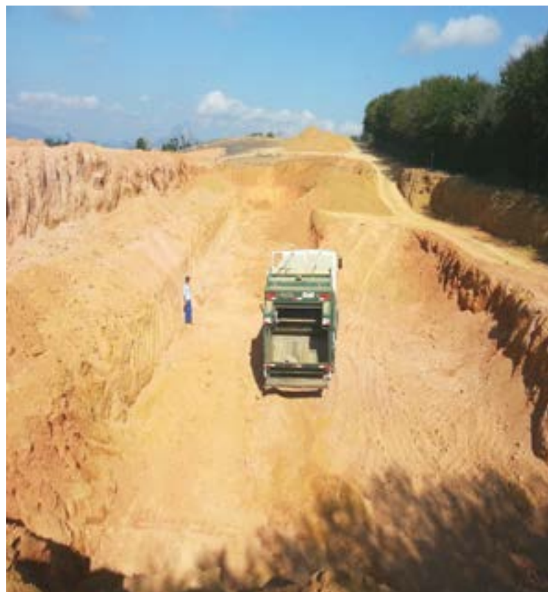
A primeira Célula Sanitária do município está em construção
