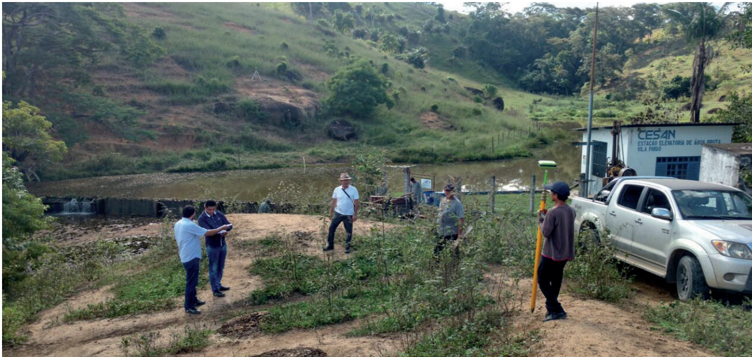
Barragem do Córrego Socorro terá capacidade para armazenar de mais 100 milhões de litros de água
