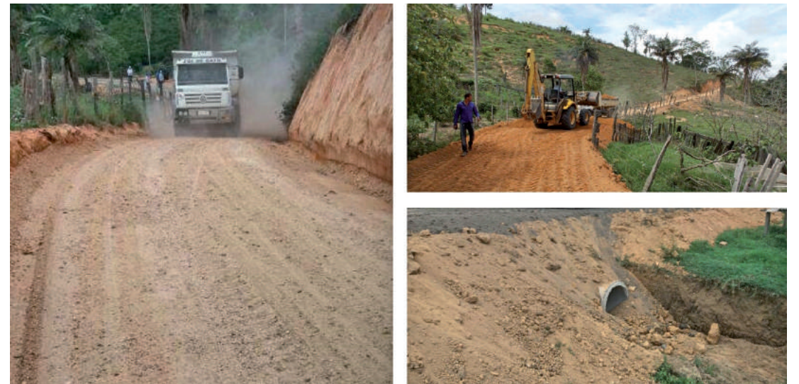
Obra de médio porte executada no Córrego Preto
