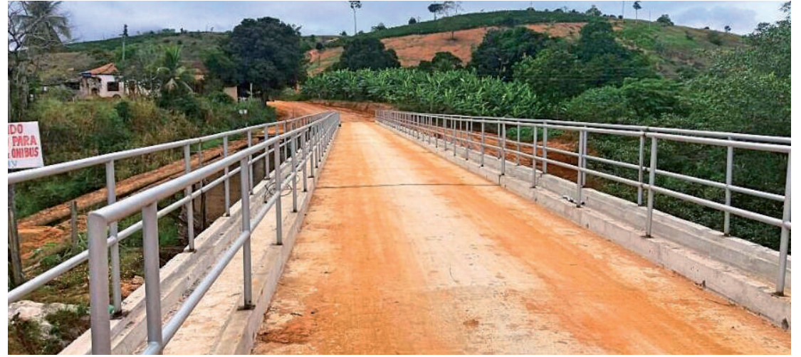
Nova ponte de São Gonçalo recebeu "Guarda Corpo" para segurança dos transeuntes
