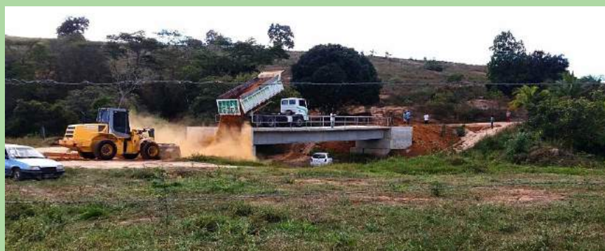
Aterro das cabeceiras da ponte sobre o Rio XV de Novembro
